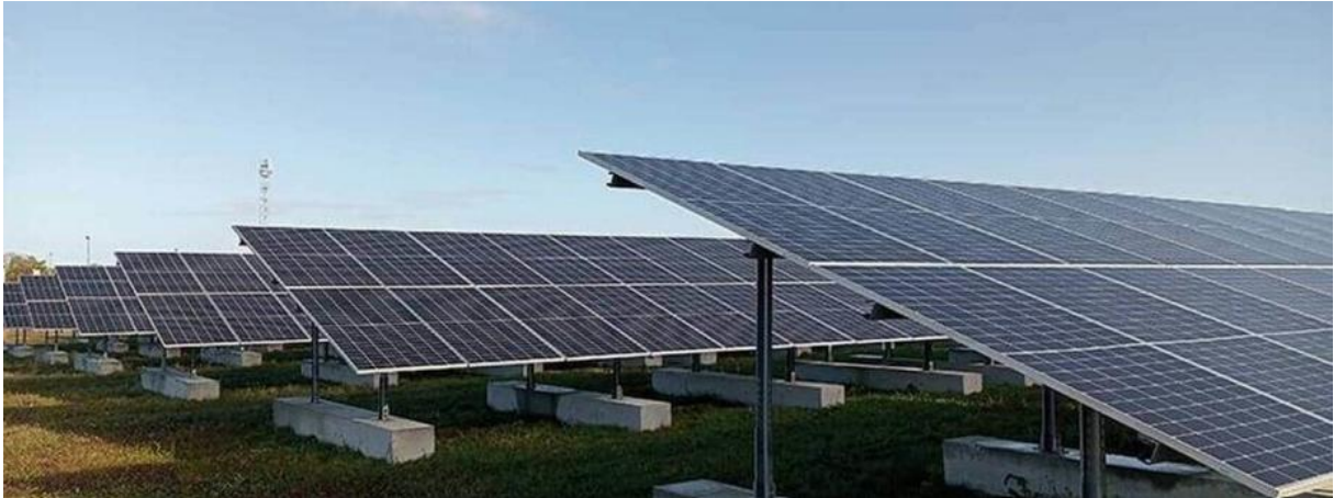
Figure 6 : Principe d'implantation de tables avec semelles isolées
